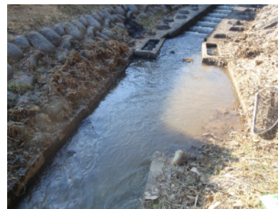
ため池の落水
