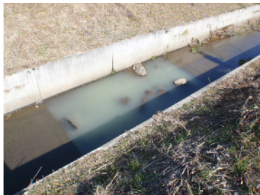
水路底の深み
