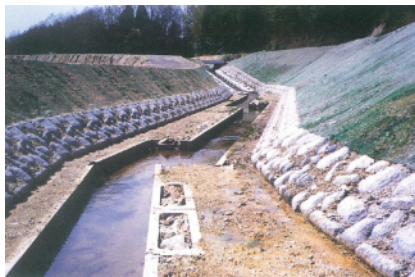
水路の折曲がり
